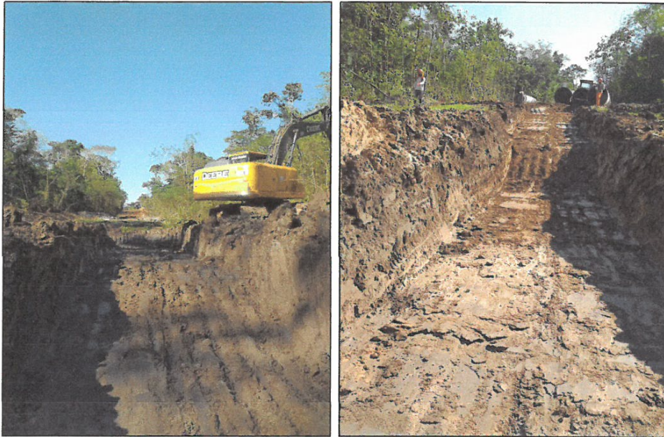
FOTO N°01 y N°02: SE VISUALIZA EL CORTE DE MATERIAL SUELTO
