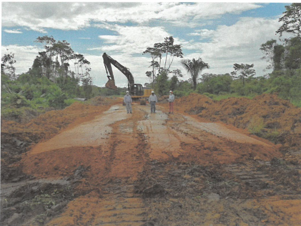
Foto N° 02.- vista se aprecia relleno para mejoramiento de sobre excavaciones en la progresiva 10+800 hasta 12+790.
