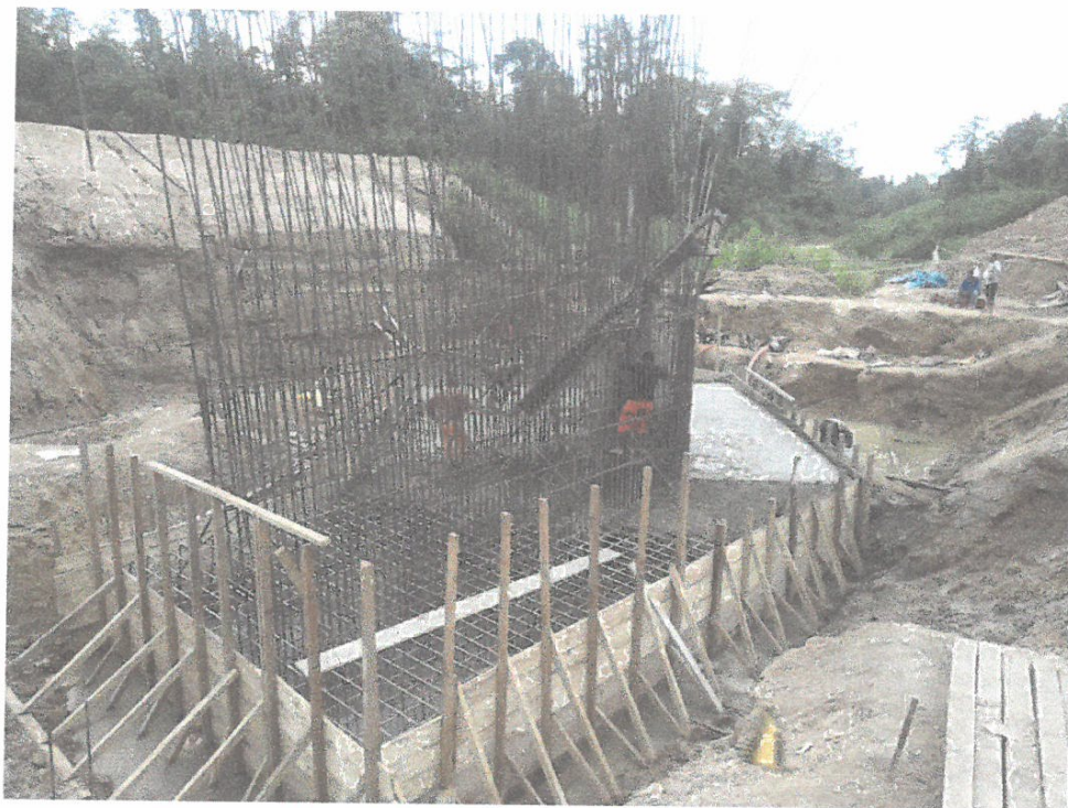
Foto N° 09.- vista se aprecia vaciado de concreto en la zapata izquierdo del puente cachiayacu.
