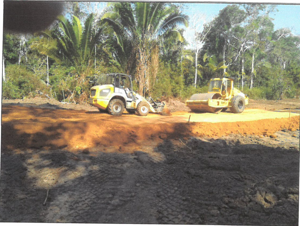
FOTO N°05: SE VISUALIZA EJECUCION DEL RELLENO A NIVEL DE SUBRAZANTE EN LA CARRETERA
