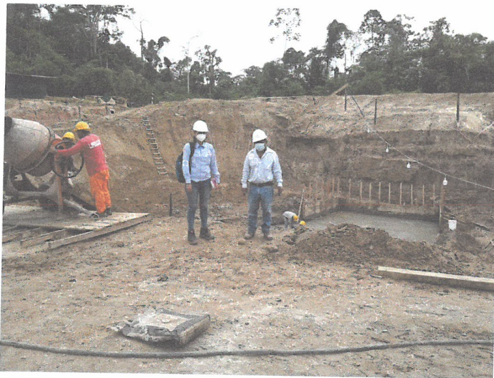
Foto N° 04.- vista se aprecia vaciado de concreto en cuentas progresiva 6+990.
