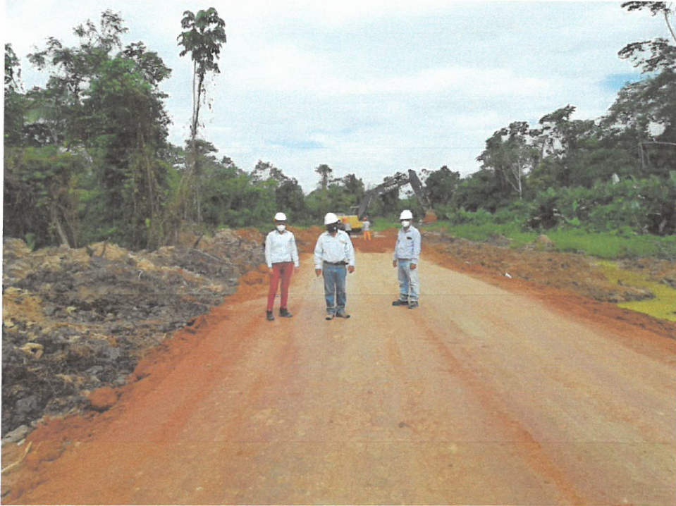
Foto N° 03.- vista se aprecia mejoramiento de sobre excavaciones, excavación de base y sub base en la progresiva 10+800 hasta 12+790.
