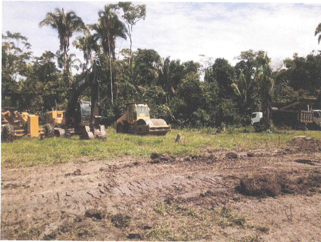
Maquinarias paralizados por lluvias en obra
