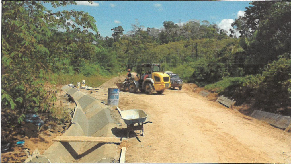
FOTO N°07: SE VISUALIZA EJECUCION DE CUNETAS EN LA IZQUIERDO Y DERECHO DE LA CARRETERA
