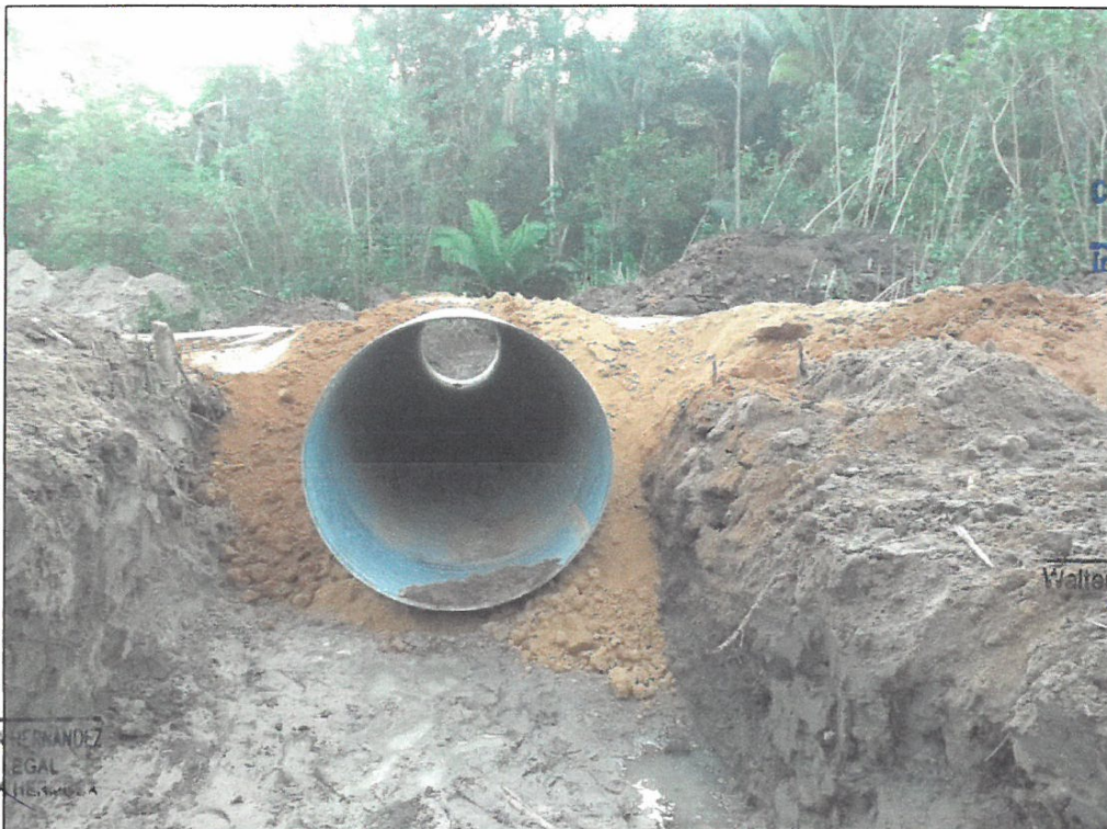
FOTO N°010: SE VISUALIZA ALCANTARILLA DE 60" COLOCADA Y RELLENADA EN OBRA
