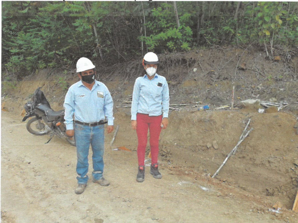
Foto N° 04.- vista se aprecia perfilado para cunetas progresiva 5+240.
