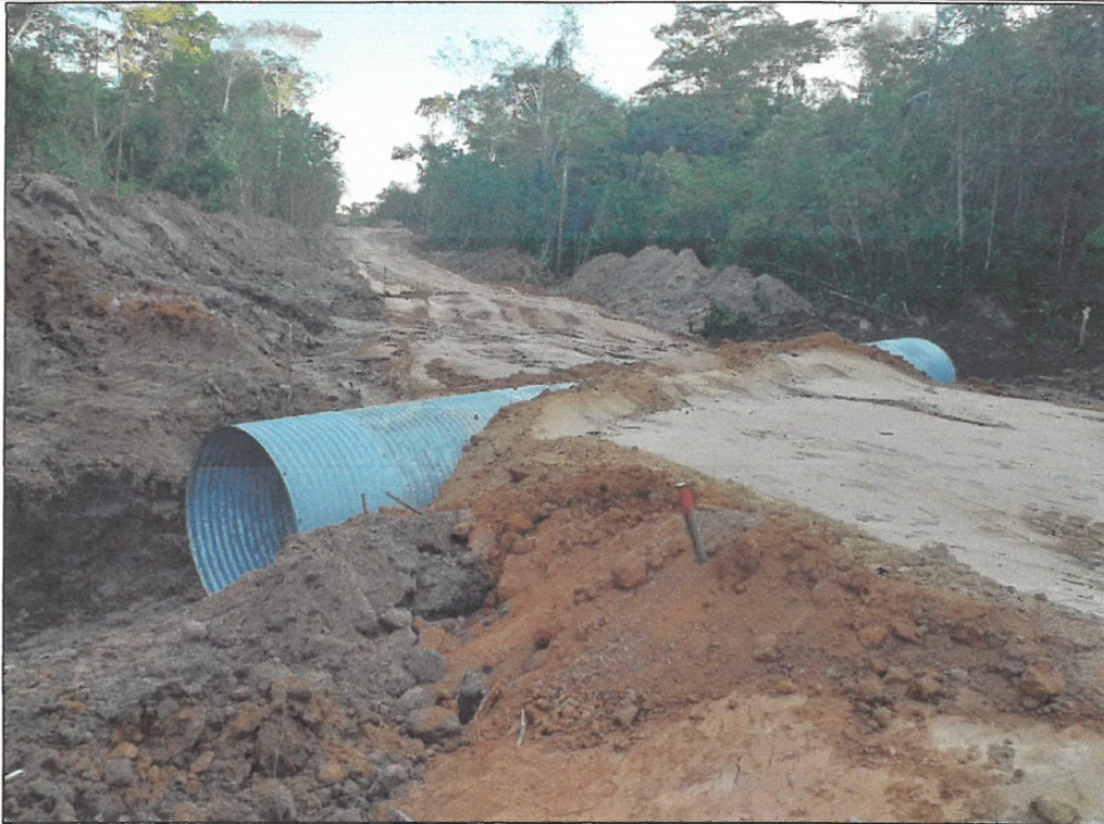
FOTO N°09: SE VISUALIZA ALCANTARILLA DE 60" COLOCADA EN CARRETERA
