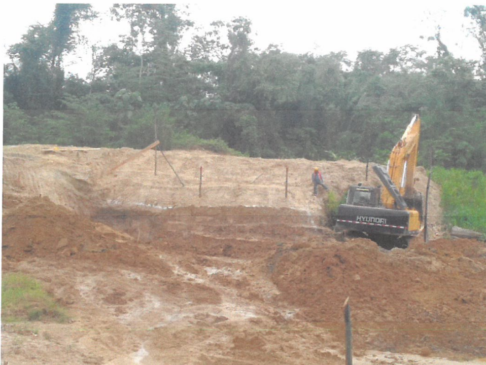
Foto N° 07.-. vista se aprecia trabajos de excavación en el Puente Cachiyacu.
