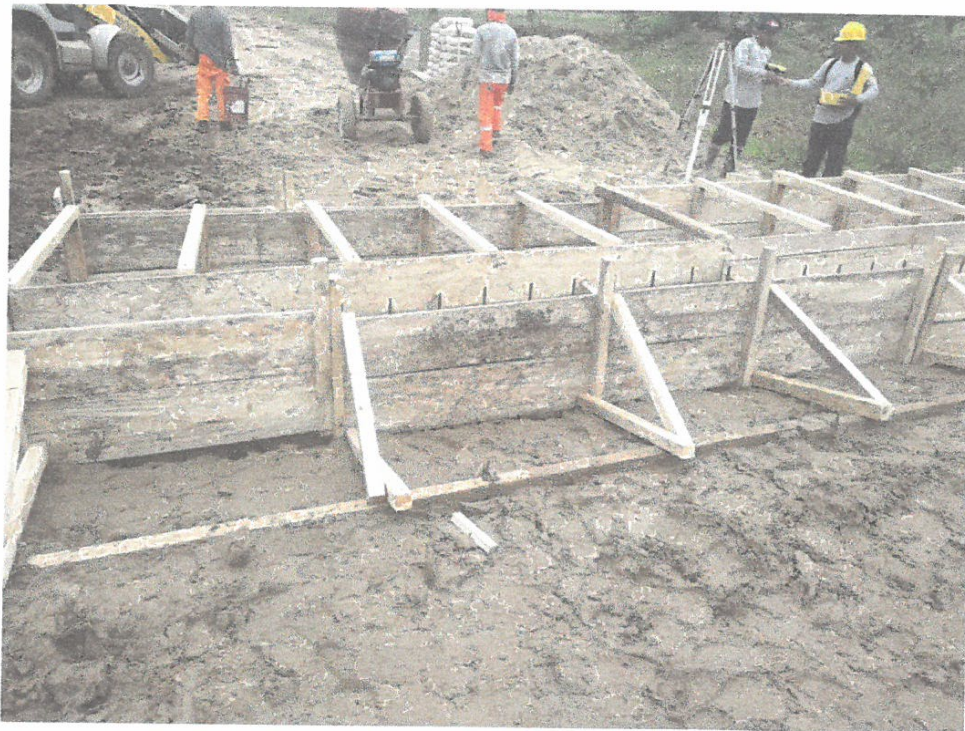
Foto N° 01.- vista se aprecia encofrado de cunetas de concreto progresiva 6+990.
