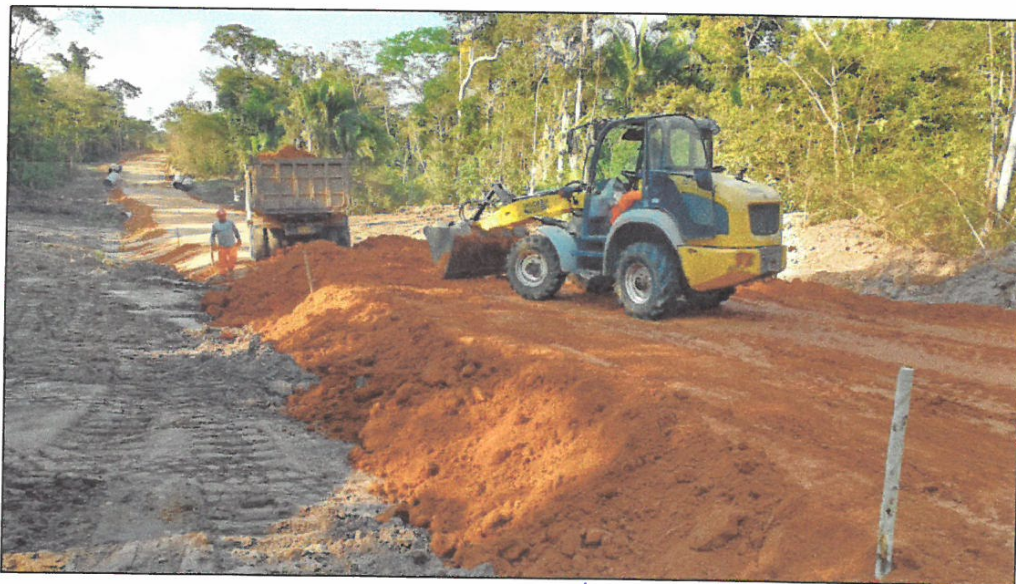
FOTO N°06: SE VISUALIZA EJECUCION DEL RELLENO A NIVEL DE SUBRAZANTE EN LA CARRETERA
