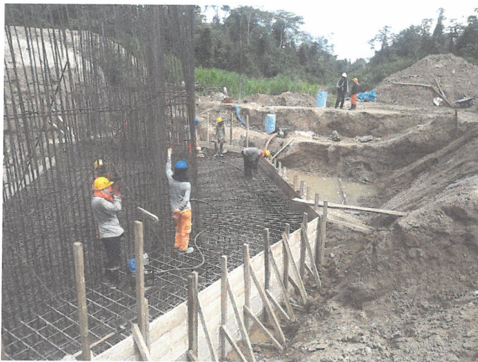
Foto N° 08.- vista se aprecia vibrado de concreto en la zapata izquierdo del puente cachiycu.
