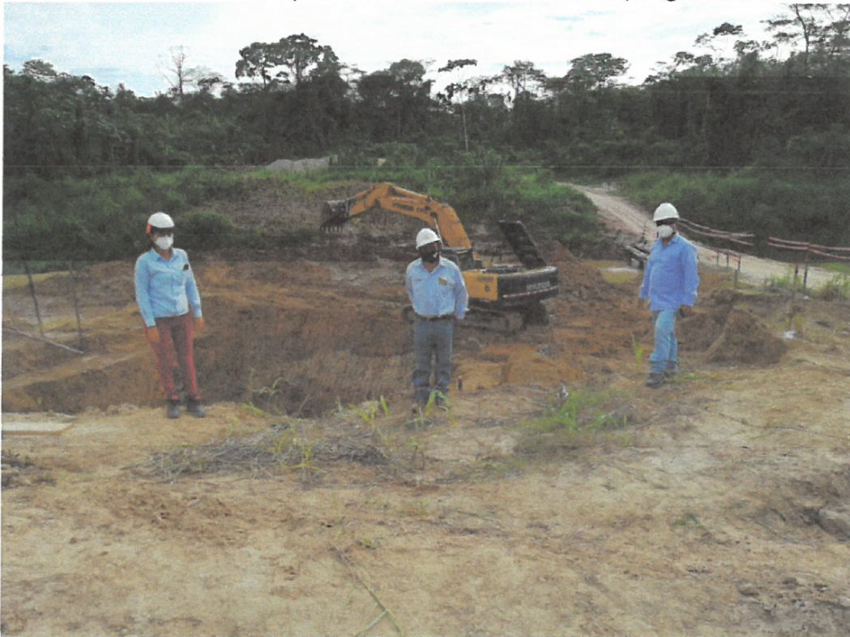
Foto N° 06.-. vista se aprecia trabajos de excavación en el Puente Cachiyacu.
