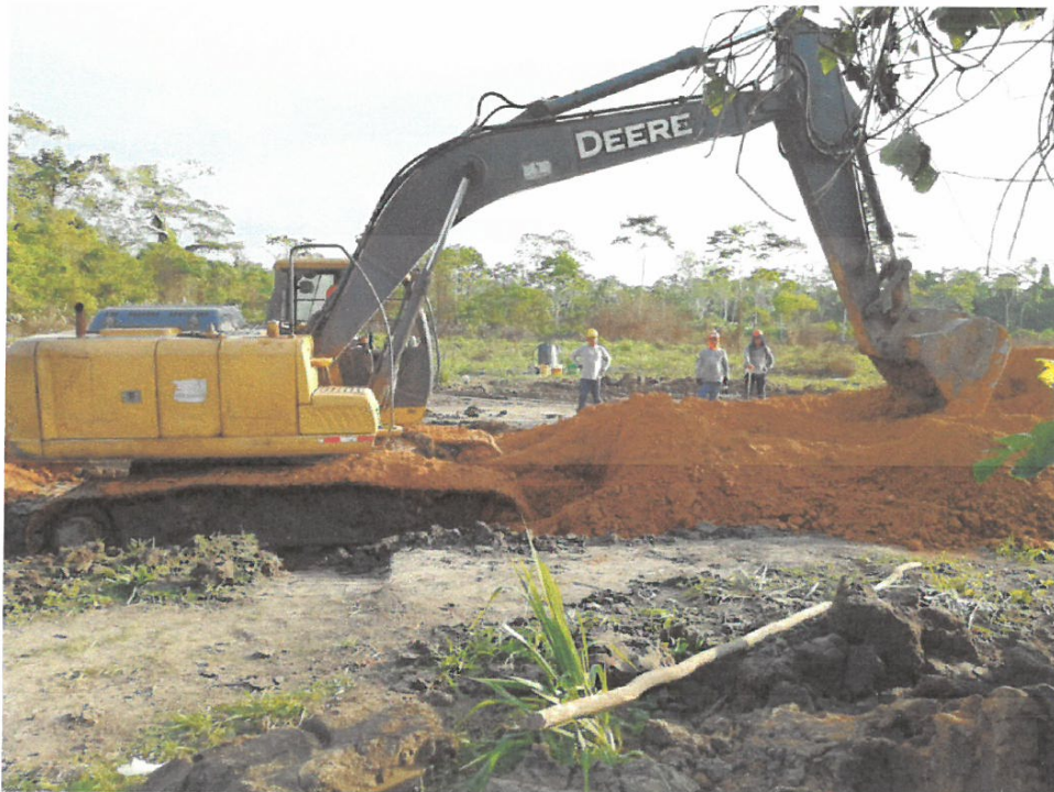
Foto N° 01.- vista se aprecia sobre excavaciones, excavación de base y sub base en la progresiva 10+800 hasta 12+790.
