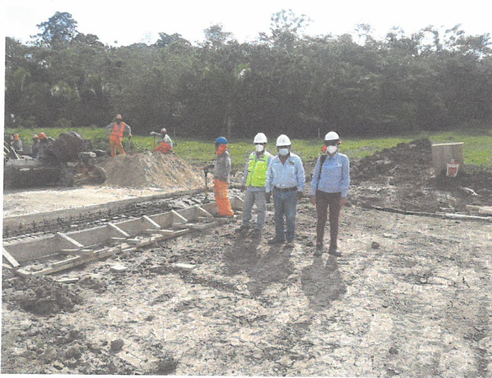
Foto N° 02.- vista se aprecia vaciado de concreto en cunetas progresiva 6+990.
