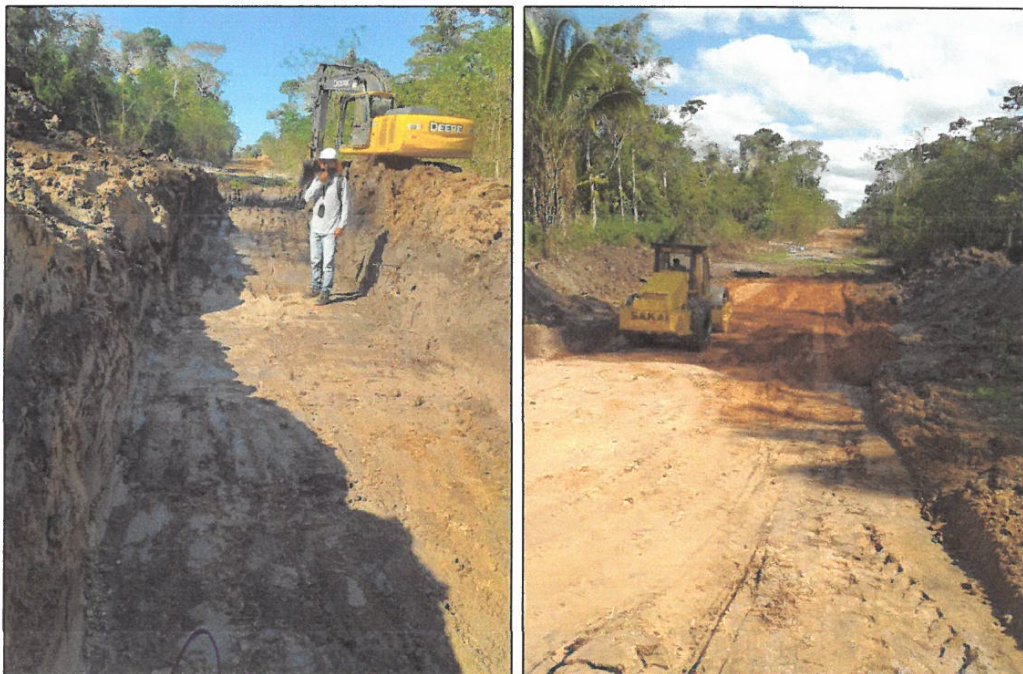
FOTO N°03 y N°04: SE VISUALIZA EL CORTE Y EL RELLENO CON MATERIAL DE PRESTAMO
