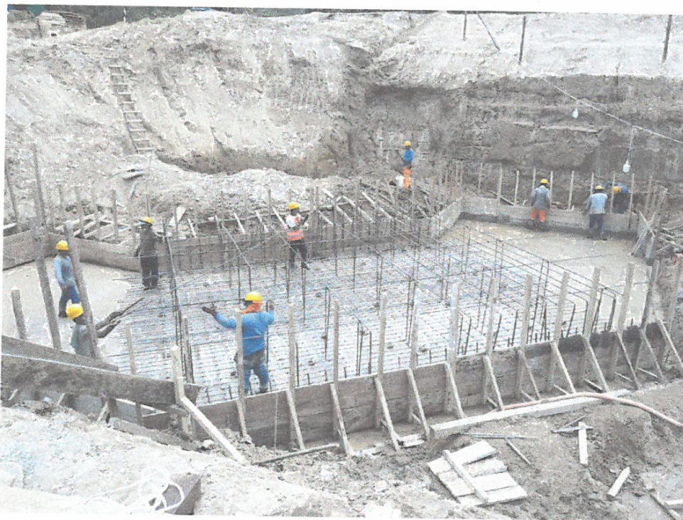
Foto N° 06.- vista se aprecia armado de estructura de doble malla para estribo de la zapata izquierdo del puente cachiyacu.
