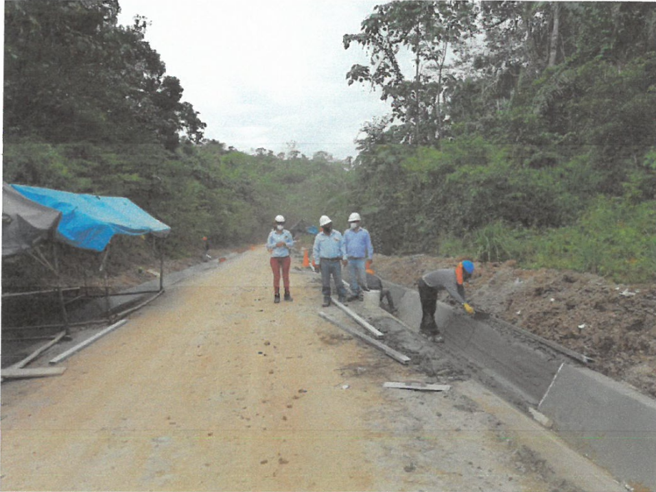
Foto N° 05.- vista se aprecia acabado de cuentas progresiva 5+240.
