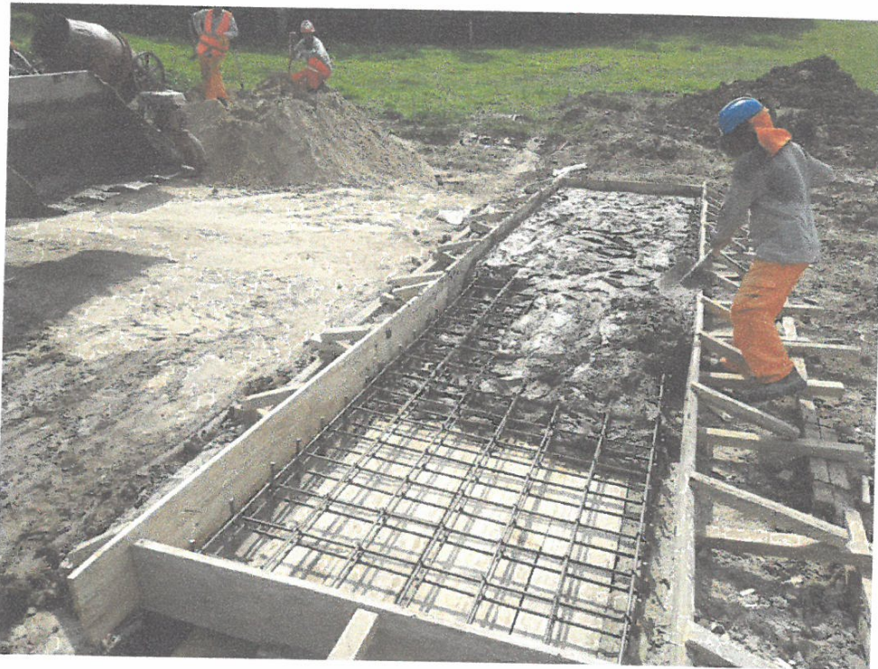
Foto N° 03.- vista se aprecia vaciado de concreto en cuentas progresiva 6+990.
